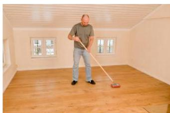
Tvrdovoskový olej vsakuje do podkladu, ale na povrchu vytvára tenkú a po vyzretí tvrdú odolnú vrstvu.
